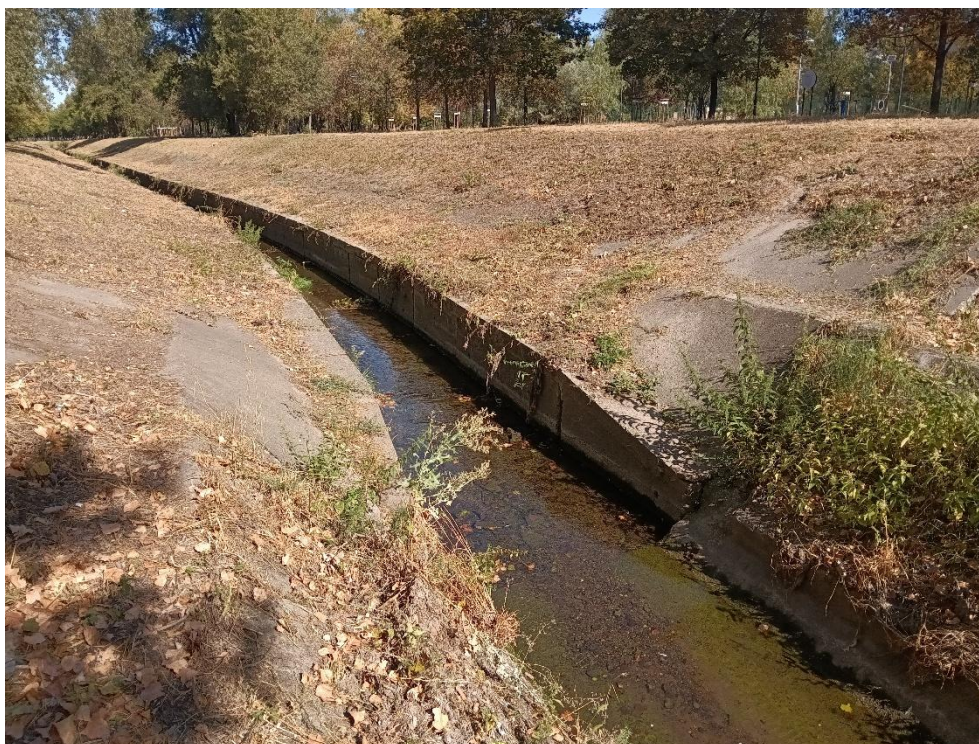
A burkolat típus váltási helye a Szilas-parki kutyafuttató magasságában.
