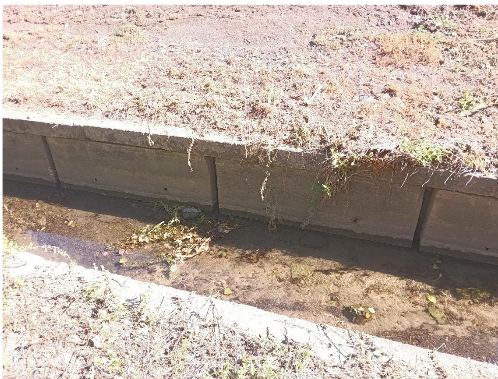
A téglalap alakú burkolat szelvény esetén az illesztési távolságok és fűrt betonáttörések.
