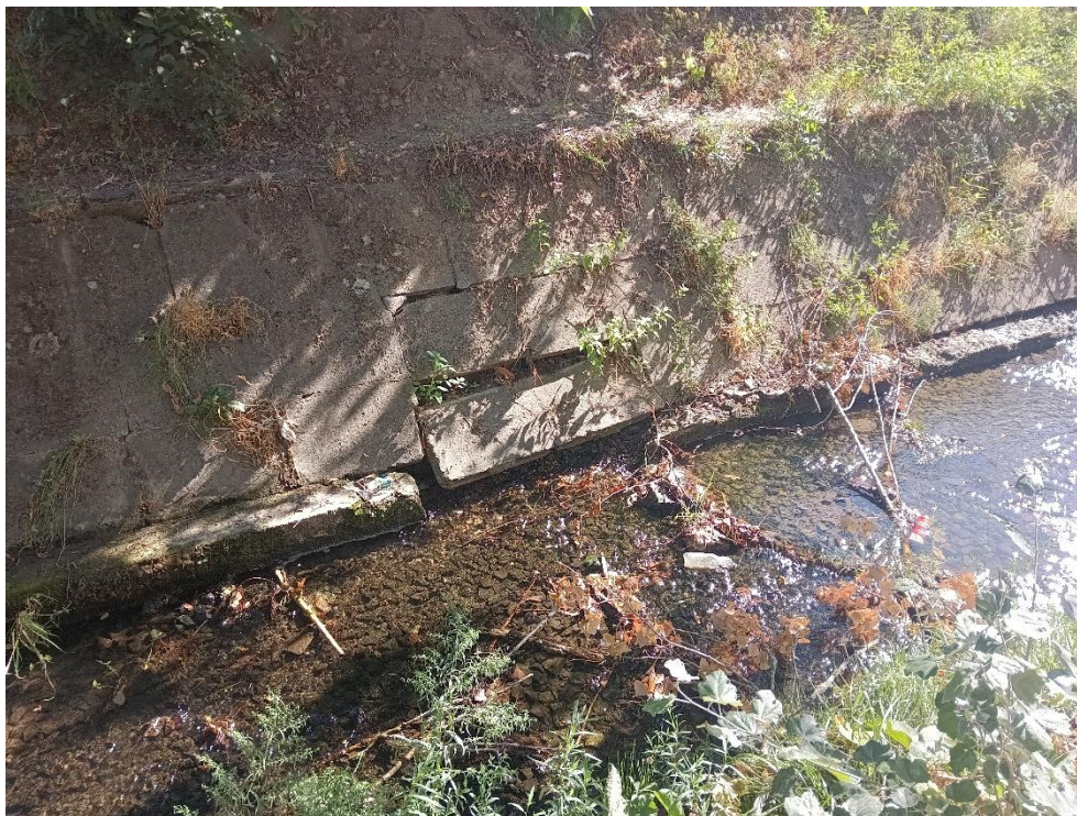
Elmozdult burkolólapok, hiányzó fugaanyag, növényzet burkolatbontó hatása.
