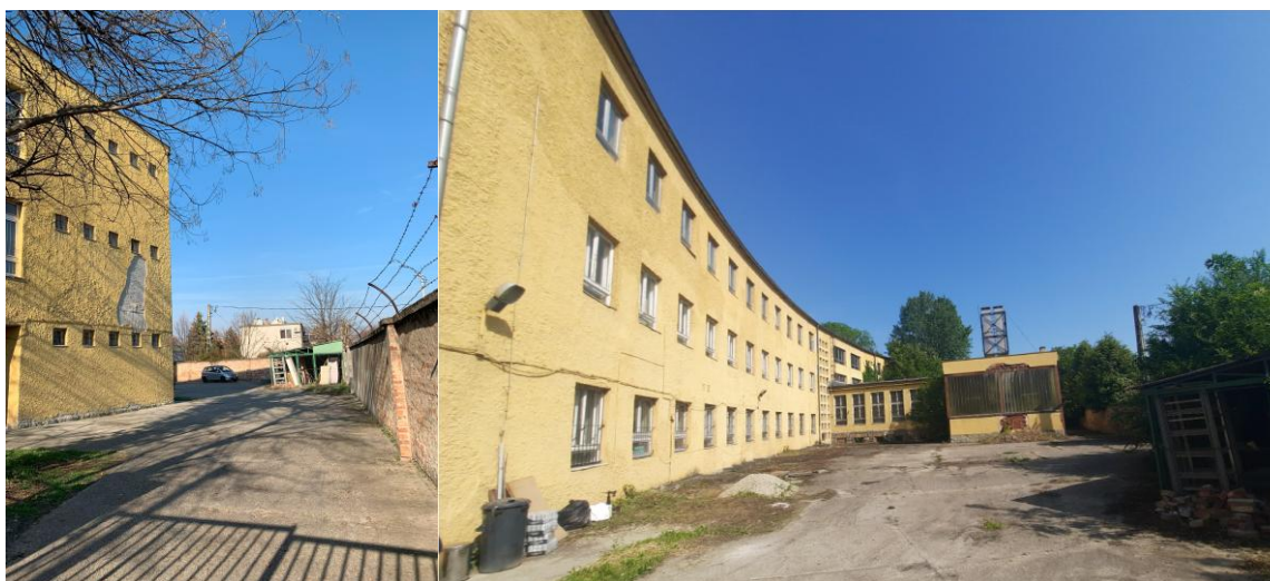
2-3. fotó: Az épület a Fóti út felőli kapubeállója felől, illetve a Németi Ernő utca felőli része a telekről (forrás: saját fénykép, 2025. március, illetve Budapest Főváros Főpolgármesteri Hivatal Várostervezési Főosztálytól kapott adatszolgáltatás)
