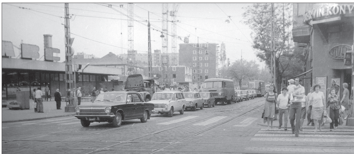
Az Árpád út–Bajcsy-Zsilinszky (ma: István) út kereszteződése az épülő és a már elkészült panelházakkal
