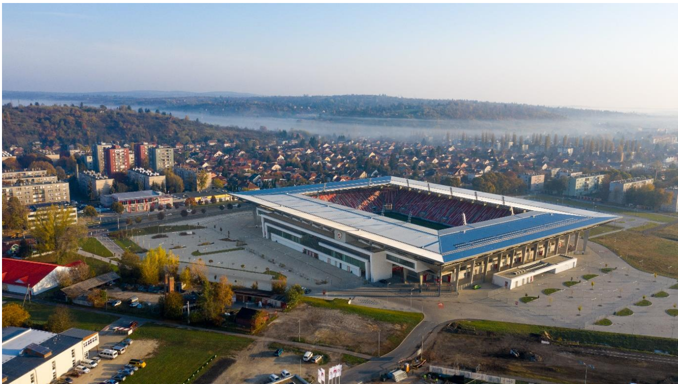
5. ábra: a DVTK-stadion látképe (forrás: https://www.hellomiskolc.hu/dvtk-stadion#photo_gallery_1-7 )
