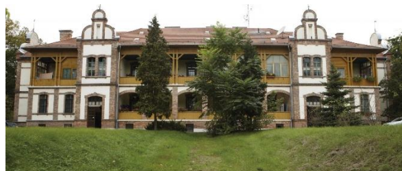
Káposztásmegyeri Vízmű szivattyúház
