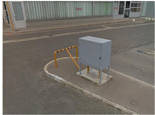
Nagyközép/kisnyomású gáznyomásszabályzó a Váci úti OMV töltőállomás és a Toyota szalon mellett
