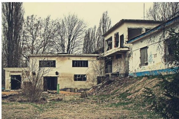
Tungsram strand leromlott állapotú épületei
