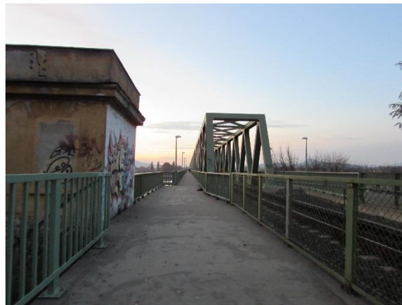
Újpesti vasúti híd
