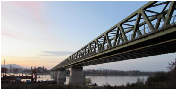
Újpesti vasúti híd
