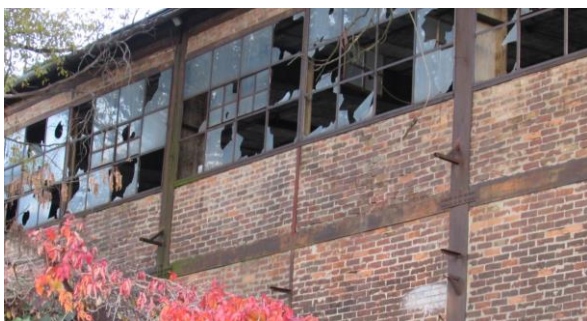
Egyik használaton kívüli gyárépület homlokzata
