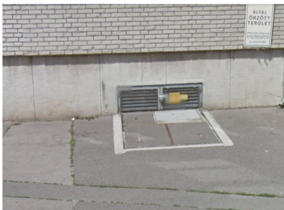
2755 sz. 10/0,4 kV-os pincében elhelyezett transzformátor
