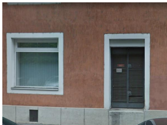
0987 sz. 10/0,4 kV-os épületben elhelyezett transzformátor
