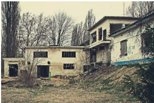
Tungsram strand leromlott állapotú épületei
