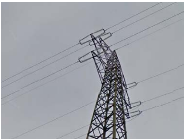
120 kV-os légvezeték rácsos tartóoszlopon a Balzsam utcában
