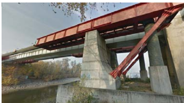
Nyomócsőpár gyalogshídon történő átvezetése (forrás: maps.google.com)
