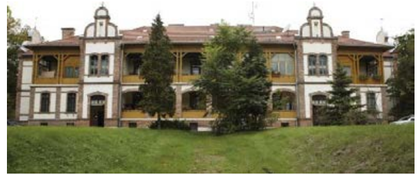
Káposztásmegyeri Vízmű szivattyúház
