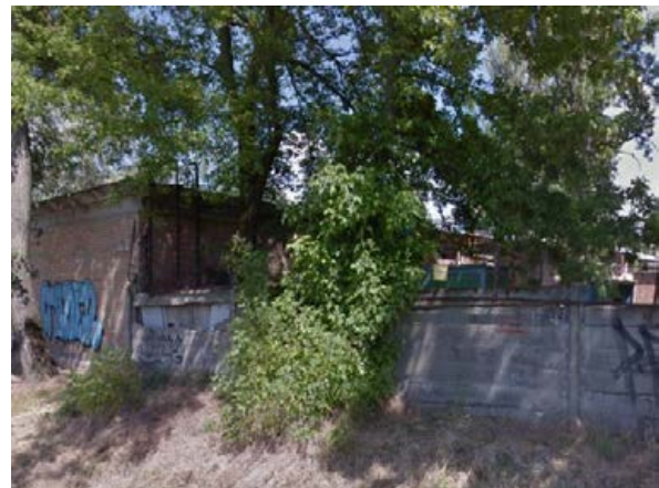
Népsziget úti gáznyomásszabályzó
