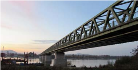
Újpesti vasúti híd
