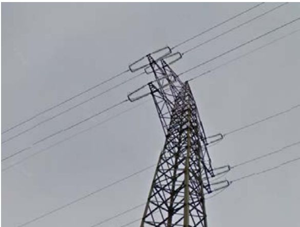
120 kV-os légvezeték rácsos tartóoszlopon a Balzsam utcában
