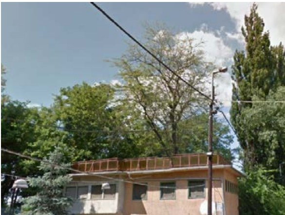
Légvezetékes kiefeszültségű erőátviteli és közvilágítási hálózat
