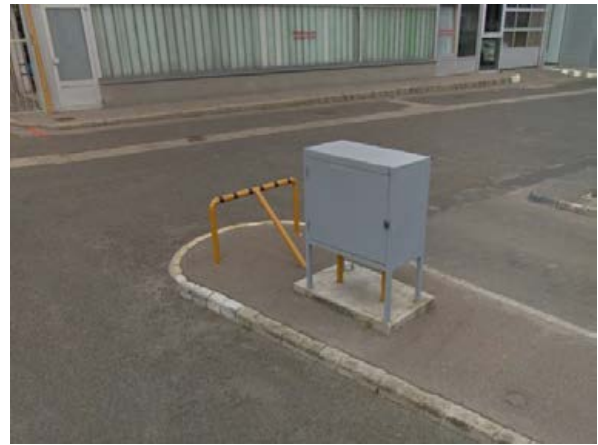
Nagyközep/kisnyomású gáznyomásszabályzó a Váci úti OMV töltőállomás és a Toyota szalon mellett
