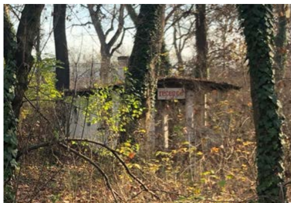
Egykori kemping fogadóépülete
