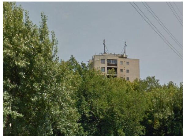
Mobil bázisállomás a Bocskai utcai társasházak tetőszerkezetén
