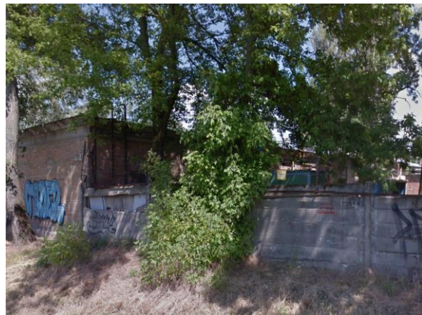
Népsziget úti gáznyomásszabályzó
