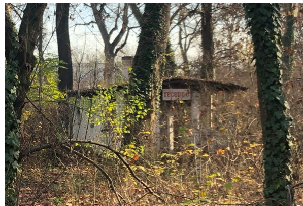
Egykori kemping fogadóépülete
