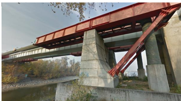
Nyomócsőpár gyalogoshídon történő átvezetése (forrás: maps.google.com)
