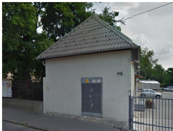
10/0,4 kV-os épületben elhelyezett transzformátor a Károlyi István utcában
