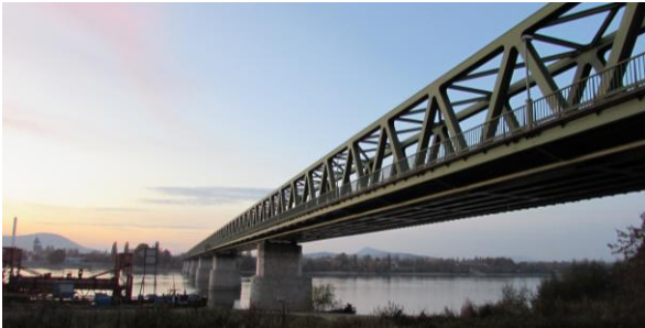
Újpesti vasúti híd
