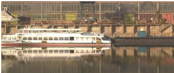
Rossz műszaki állapotú támfalak
