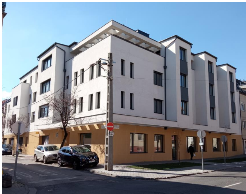
5. ábra: Károlyi István utca 25. szám alatti felépült önkormányzati társasház
