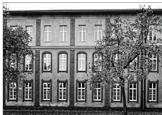
A Tanoda téri iskola homlokzati részlete
