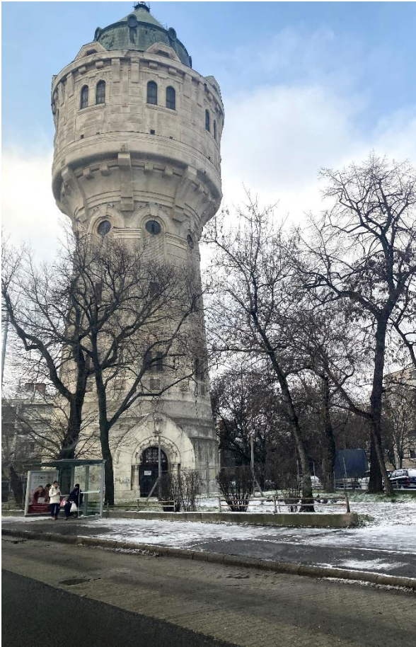
4. Víztorony az Árpád út felől
