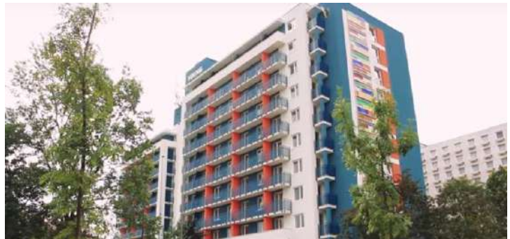
Új erkélyek építésével korszerűsített épület (Püskösdűfő 38.)
