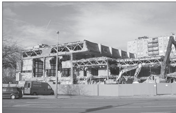
Az acél vázszerkezet a 2018. januári bontás során
