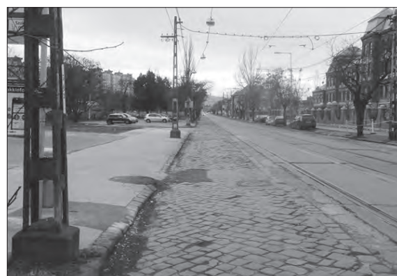
1927-ben fektetett bazaltkockákból álló úttest és felsővezeték-tartó oszlopok 2015 februárjában (A szerző felvétele)
