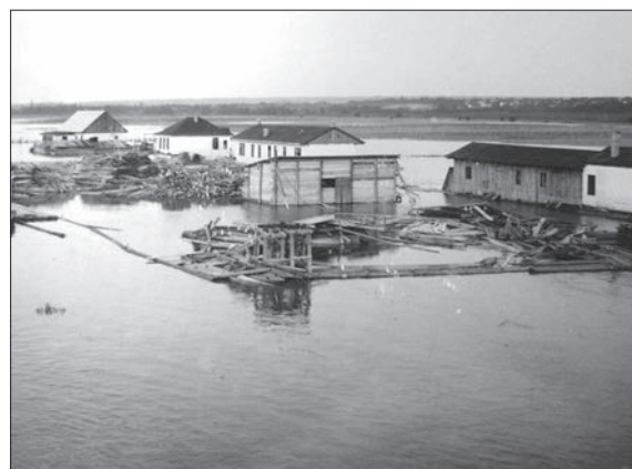
Az elöntött építési terület
