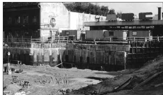
Munkagödör a mai Match előtt. Jól érezhető, hol helyezkednek el a peronszintről az aluljáró szintjére felvezető (mozgó) lépcsők
