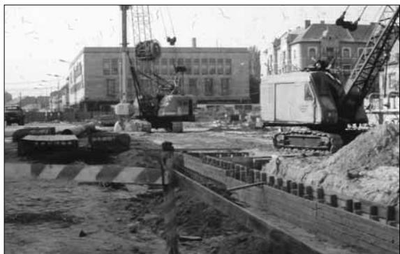
Réselőgép és daru a lebontott házak helyén a metróépítés kezdeti fázisában, 1986 nyarán
