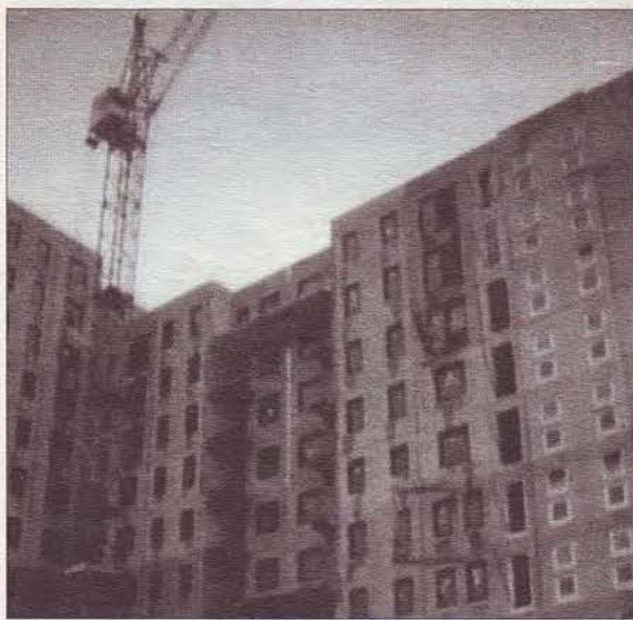
Előregyártott elemekből épülő panelház
