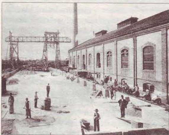
A bakdaru, a széntér, a kazán- és gépház építése
