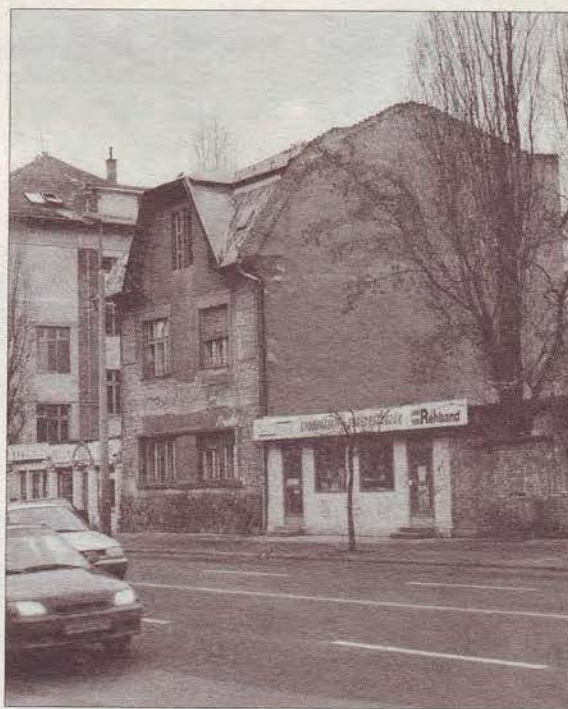
Újpest, Árpád Kórház igazgatói villalakás, épült 1938-ban
