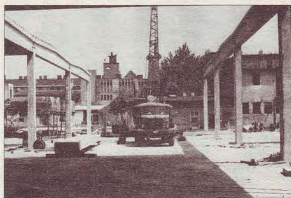
A szerkezet szerelése a max. 10t teherbírású autódarúval (báttérben az Újpesti Tűzoltóság tűztornyával)
