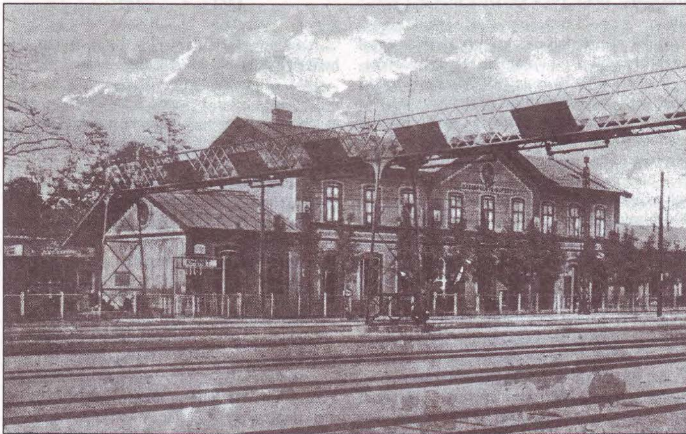
A Rákospalota-Újpest vasútállomás képe a '20-as években
