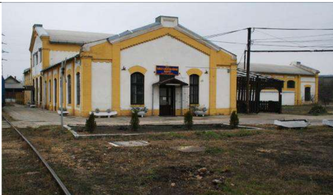
Jellemző homlokzati fotó
