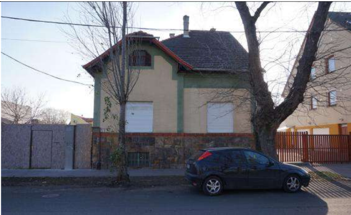
Jellemző homlokzati fotó
