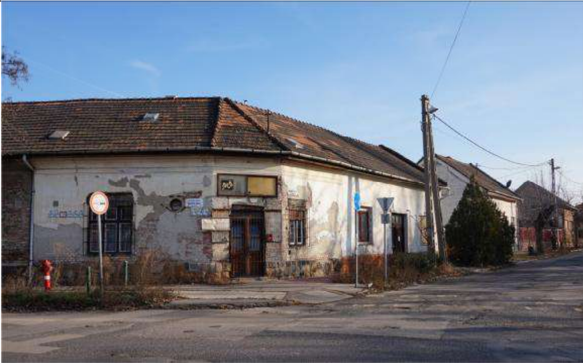
Jellemző homlokzati fotó
