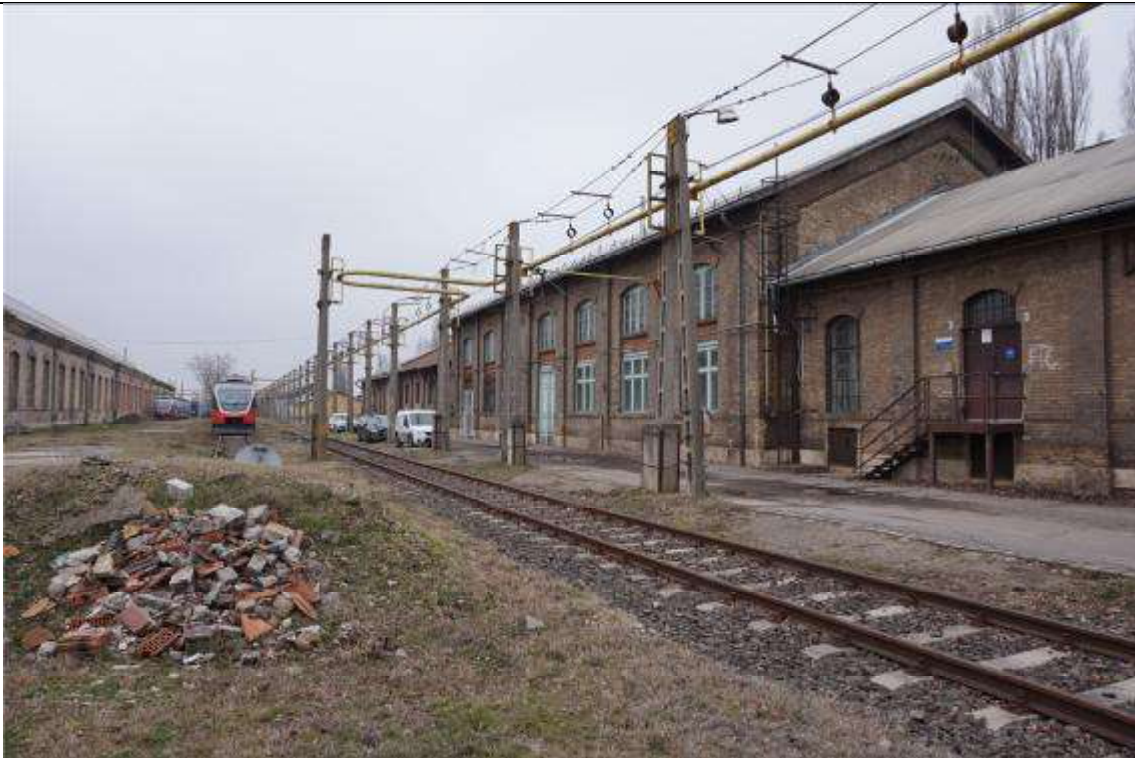
Jellemző homlokzati fotó
