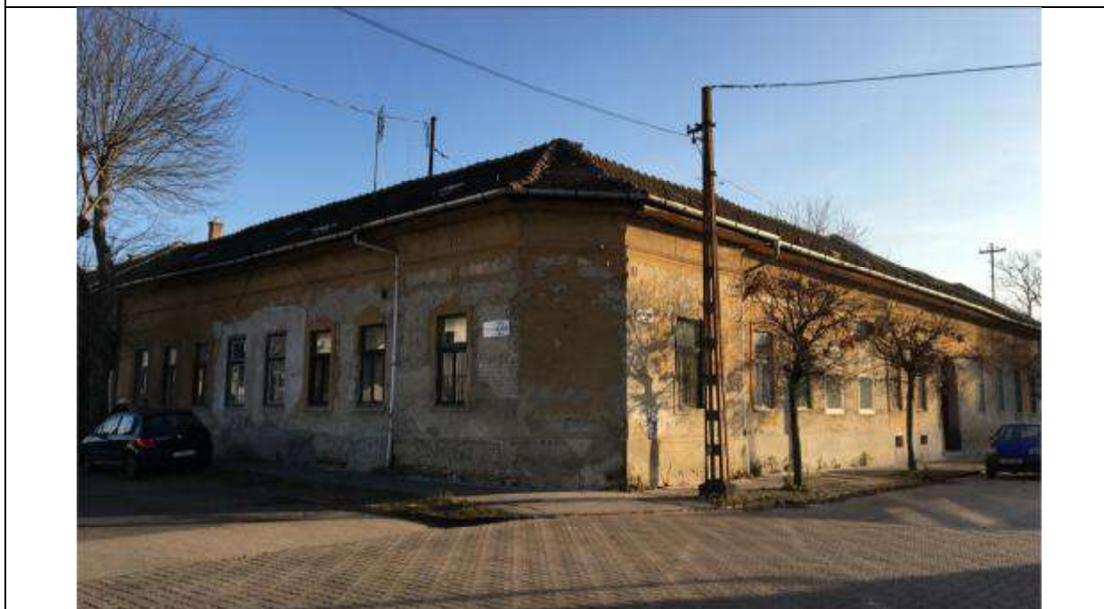
Jellemző homlokzati fotó
