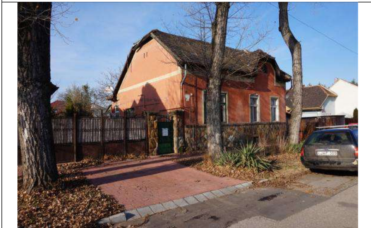
Jellemző homlokzati fotó
