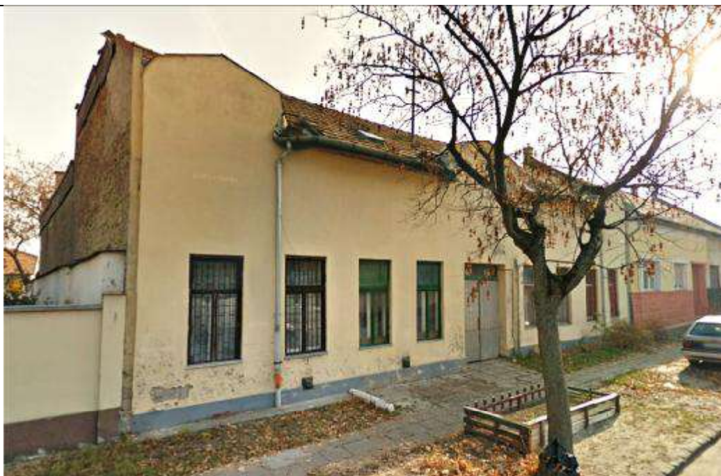
Jellemző homlokzati fotó
