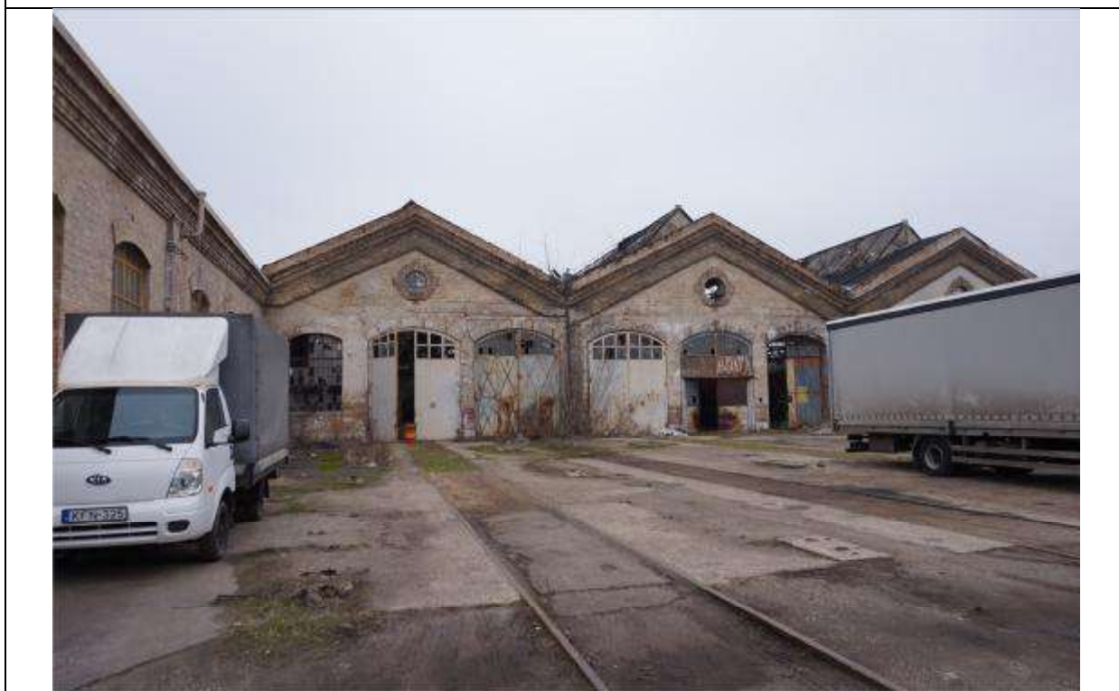
Jellemző homlokzati fotó
