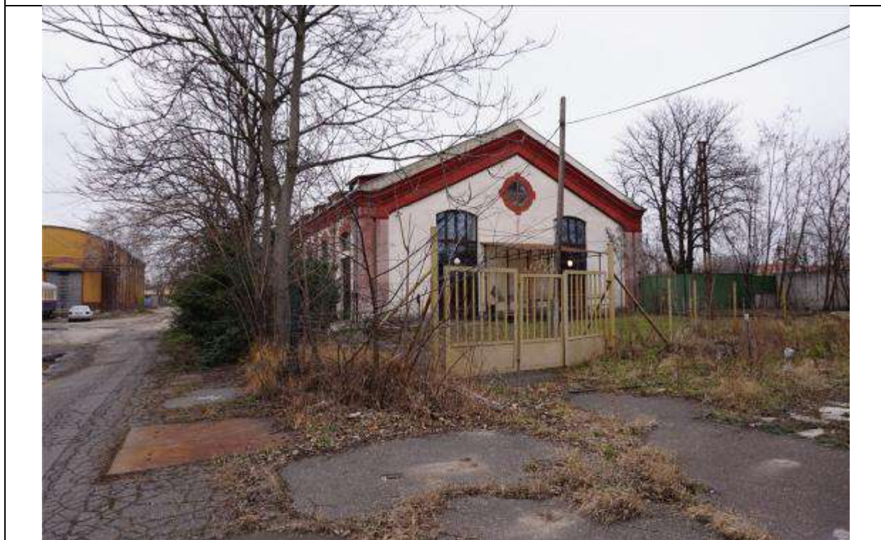
Jellemző homlokzati fotó
