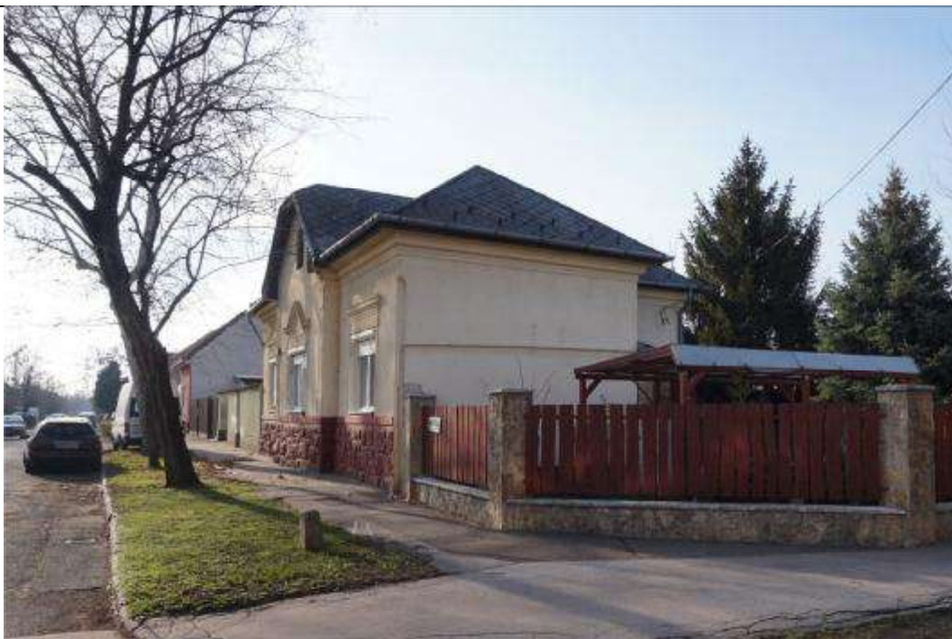
Jellemző homlokzati fotó
