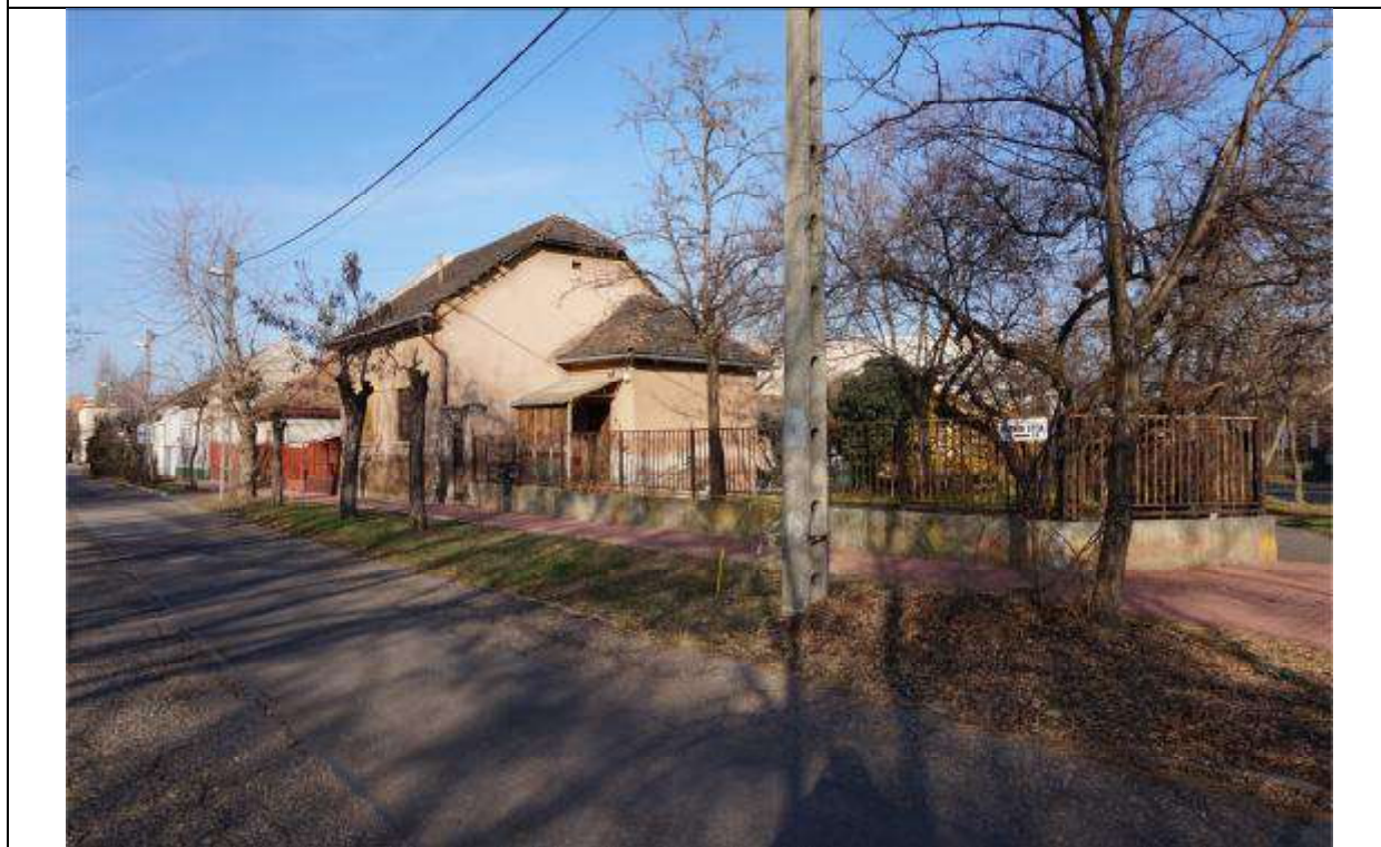
Jellemző homlokzati fotó
