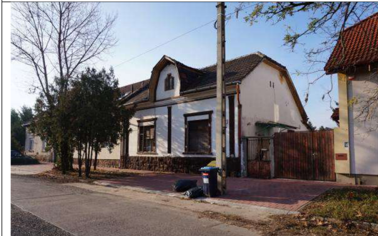
Jellemző homlokzati fotó
