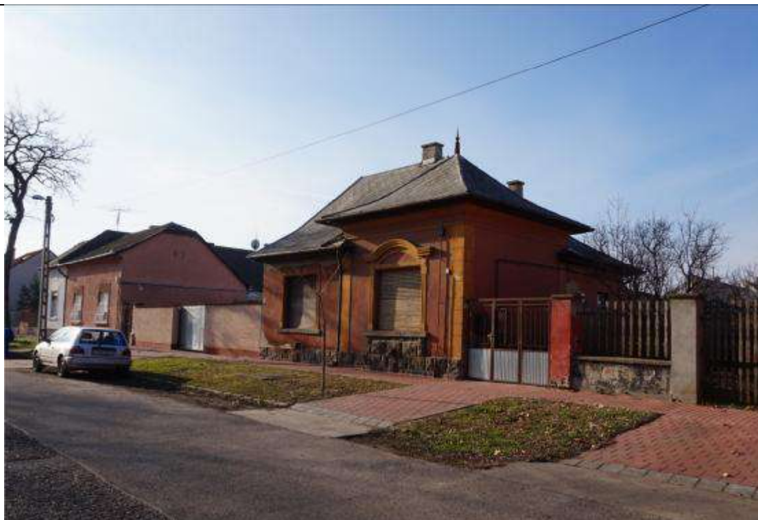
Jellemző homlokzati fotó
