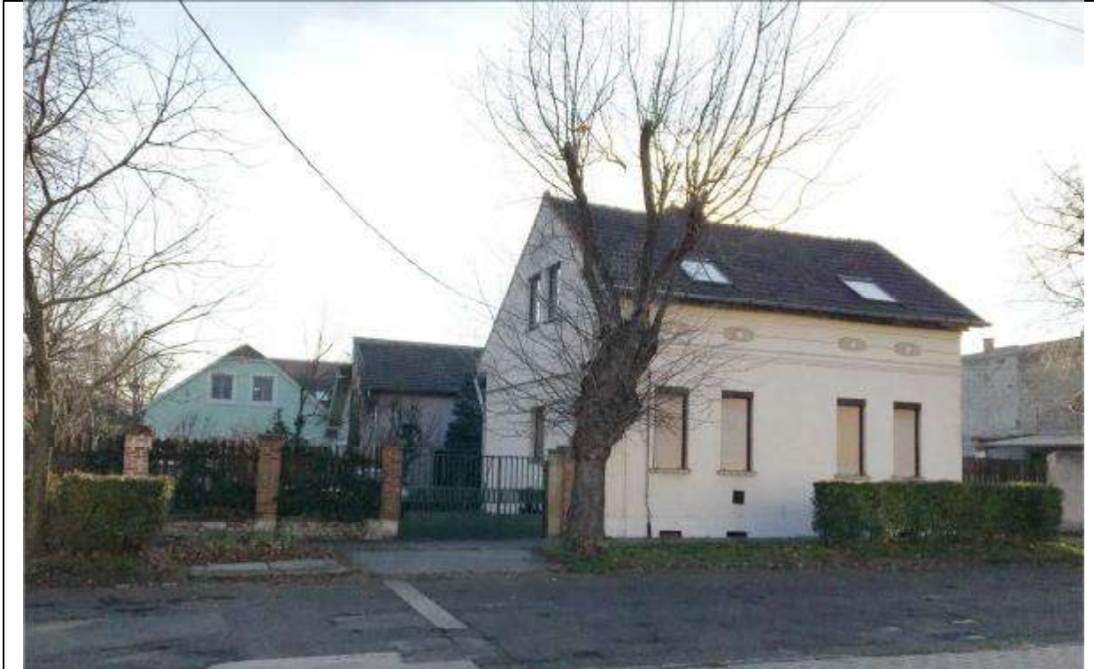
Jellemző homlokzati fotó
