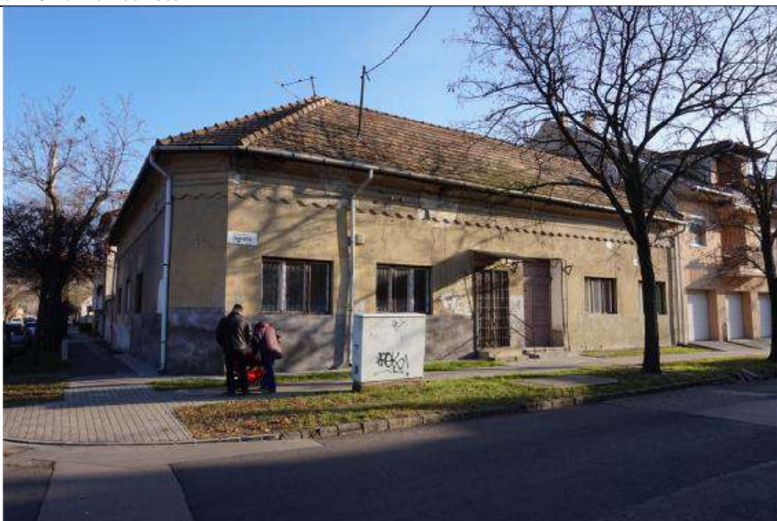
Jellemző homlokzati fotó
