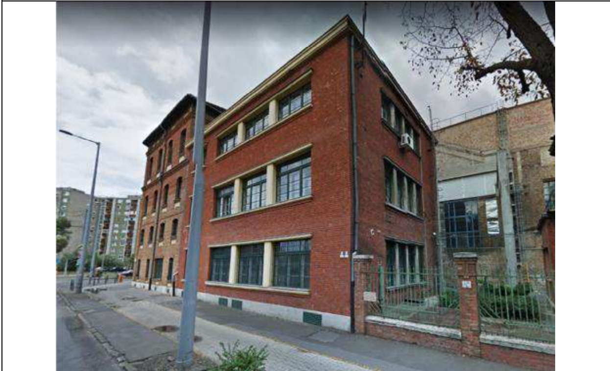
Jellemző homlokzati fotó
