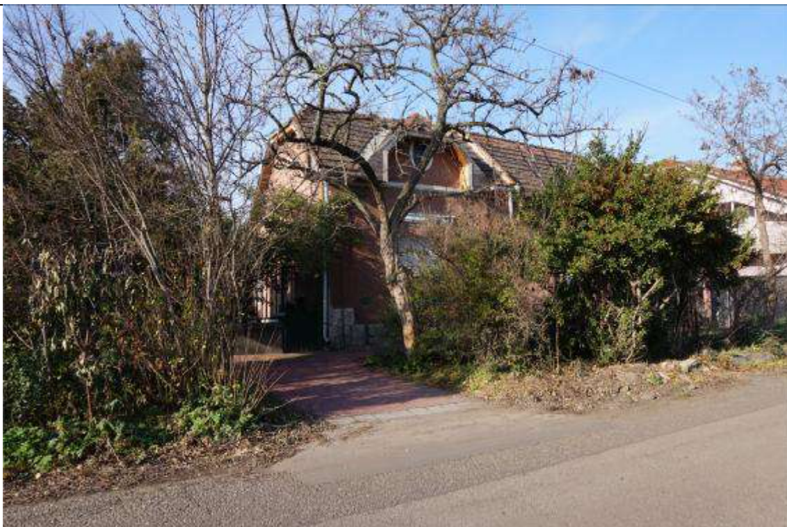
Jellemző homlokzati fotó
