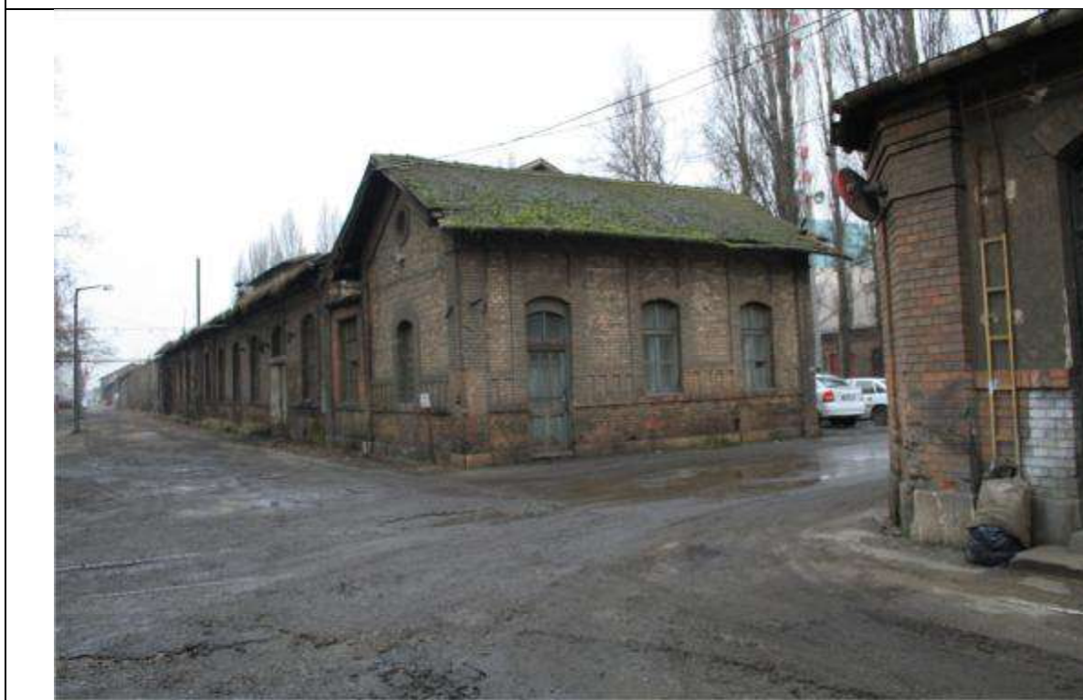
Jellemző homlokzati fotó
