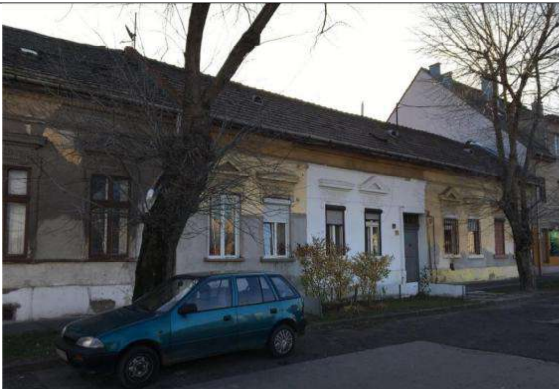
Jellemző homlokzati fotó
