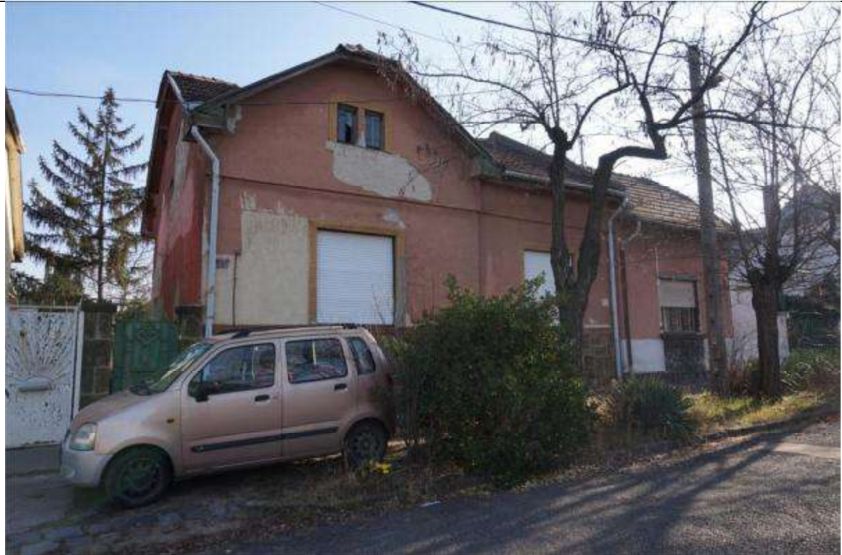
Jellemző homlokzati fotó
