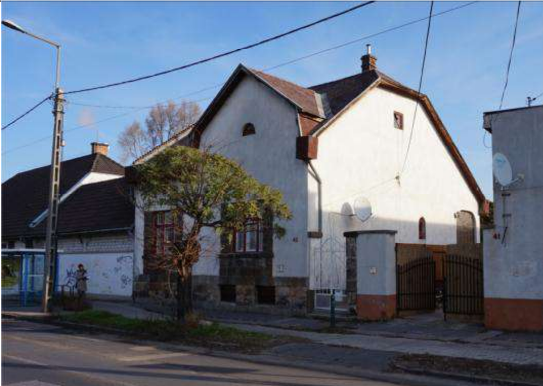
Jellemző homlokzati fotó
