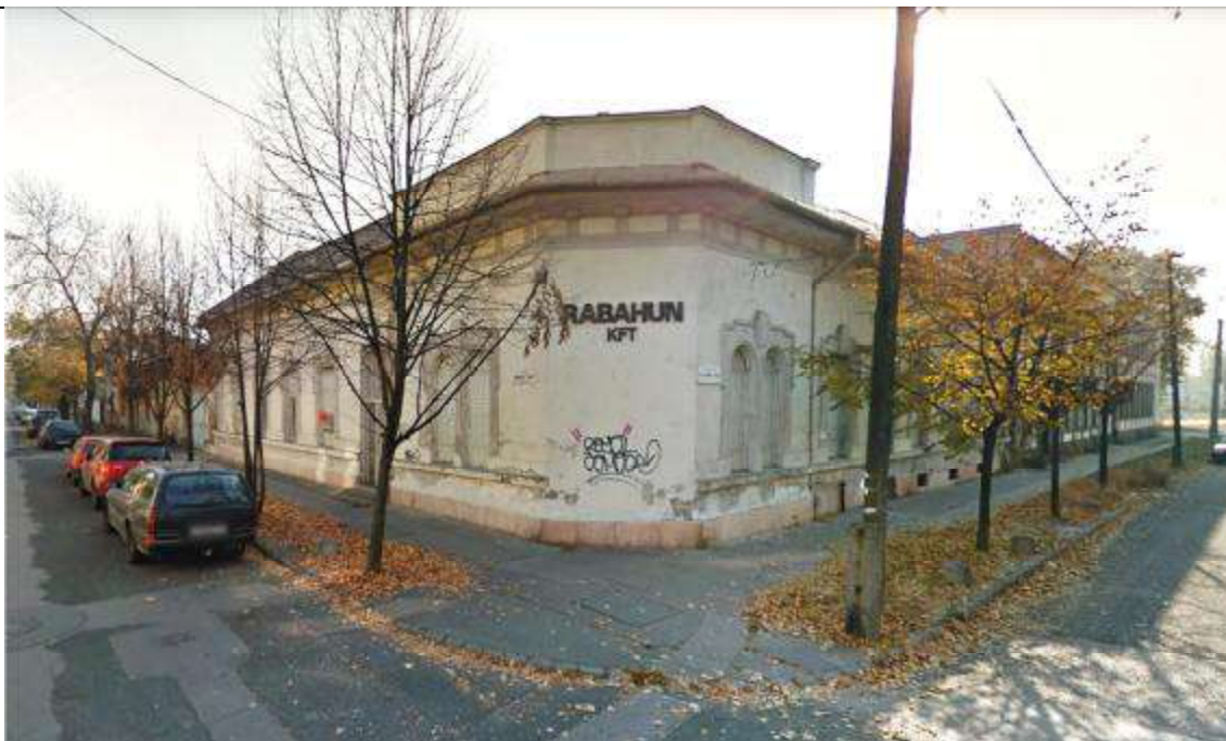
Jellemző homlokzati fotó
