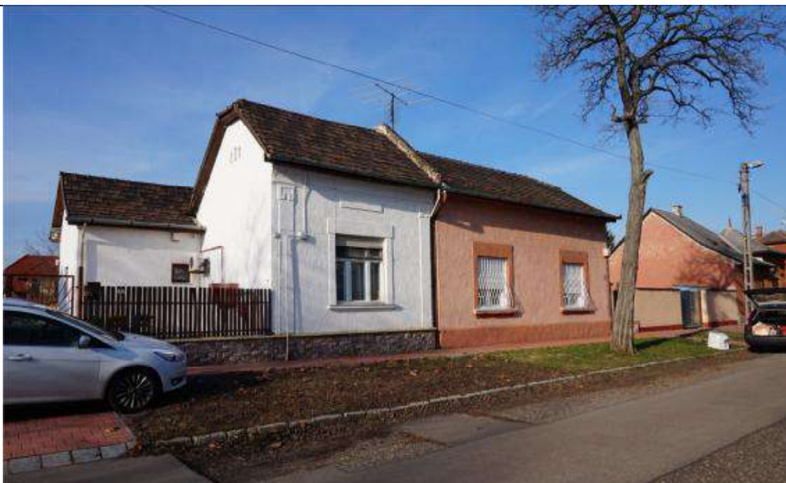
Jellemző homlokzati fotó
