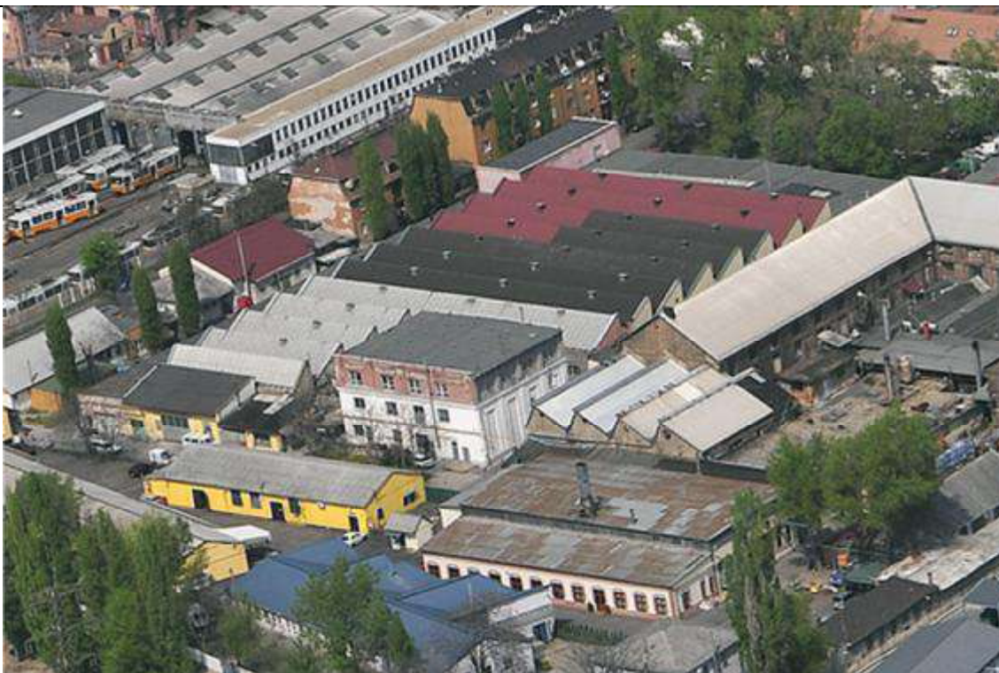
Jellemző homlokzati fotó
