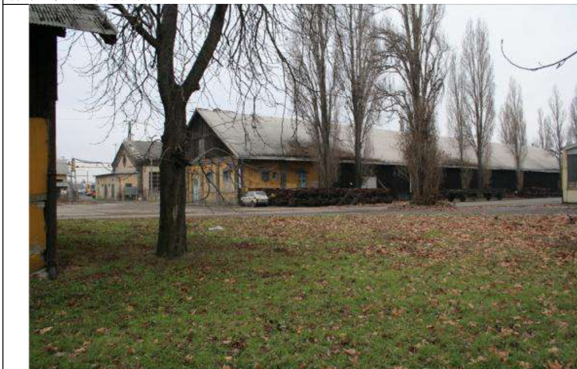
Jellemző homlokzati fotó
