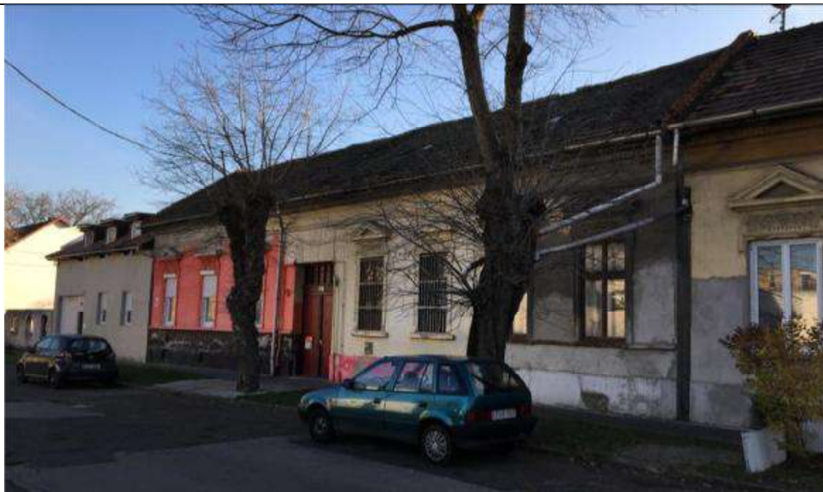
Jellemző homlokzati fotó
