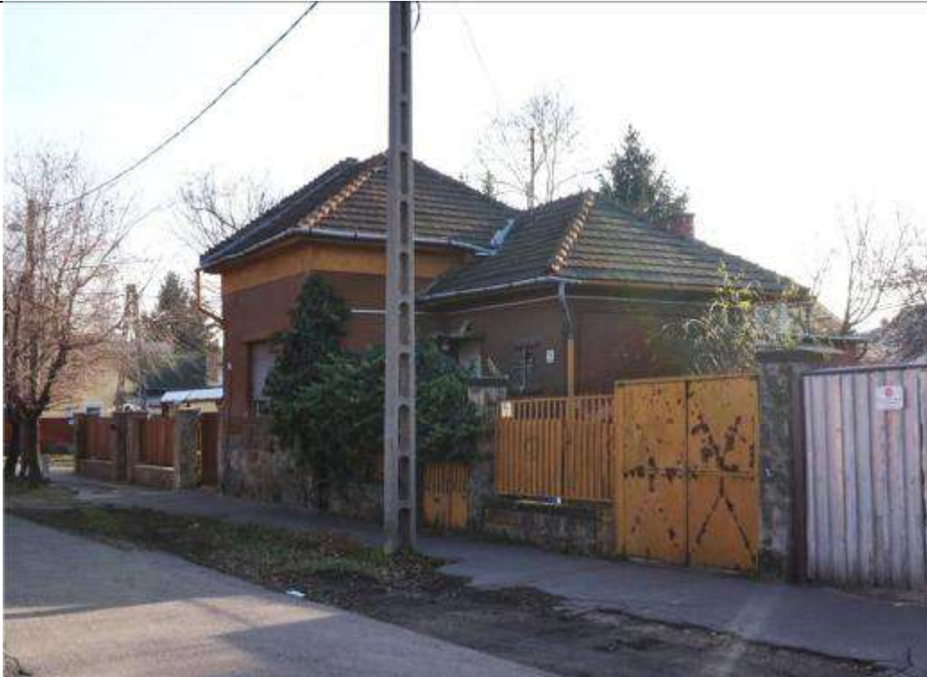
Jellemző homlokzati fotó
