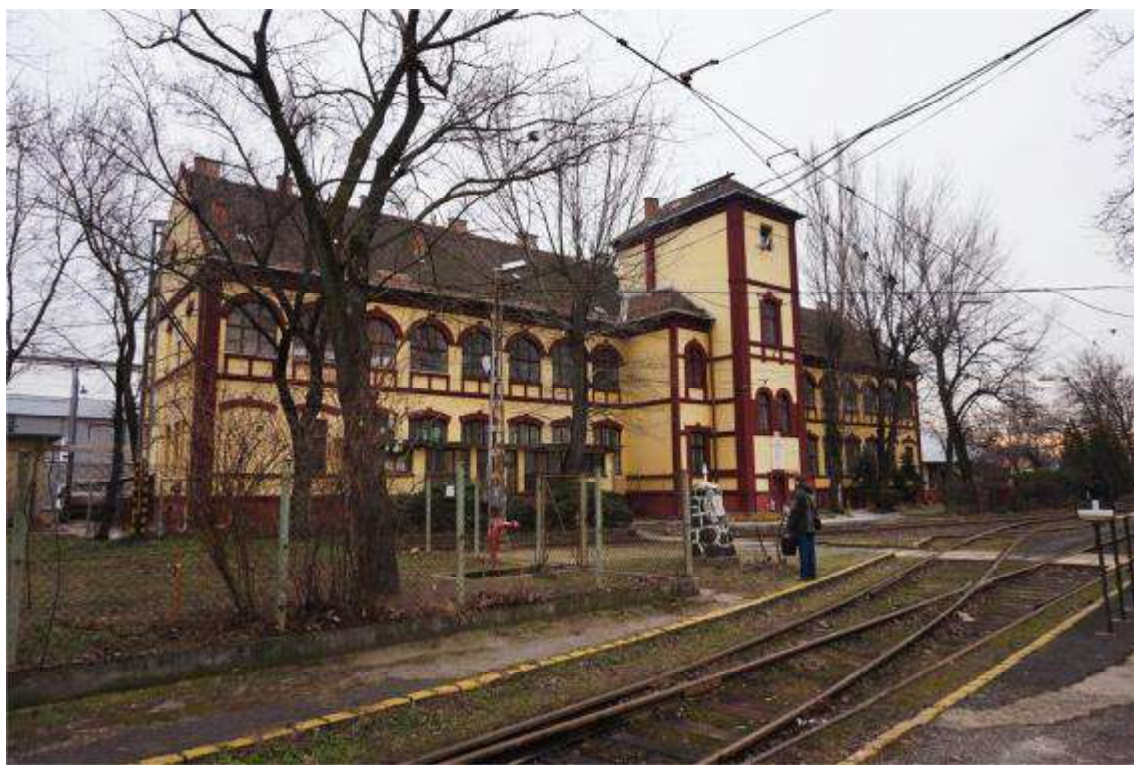
Jellemző homlokzati fotó
