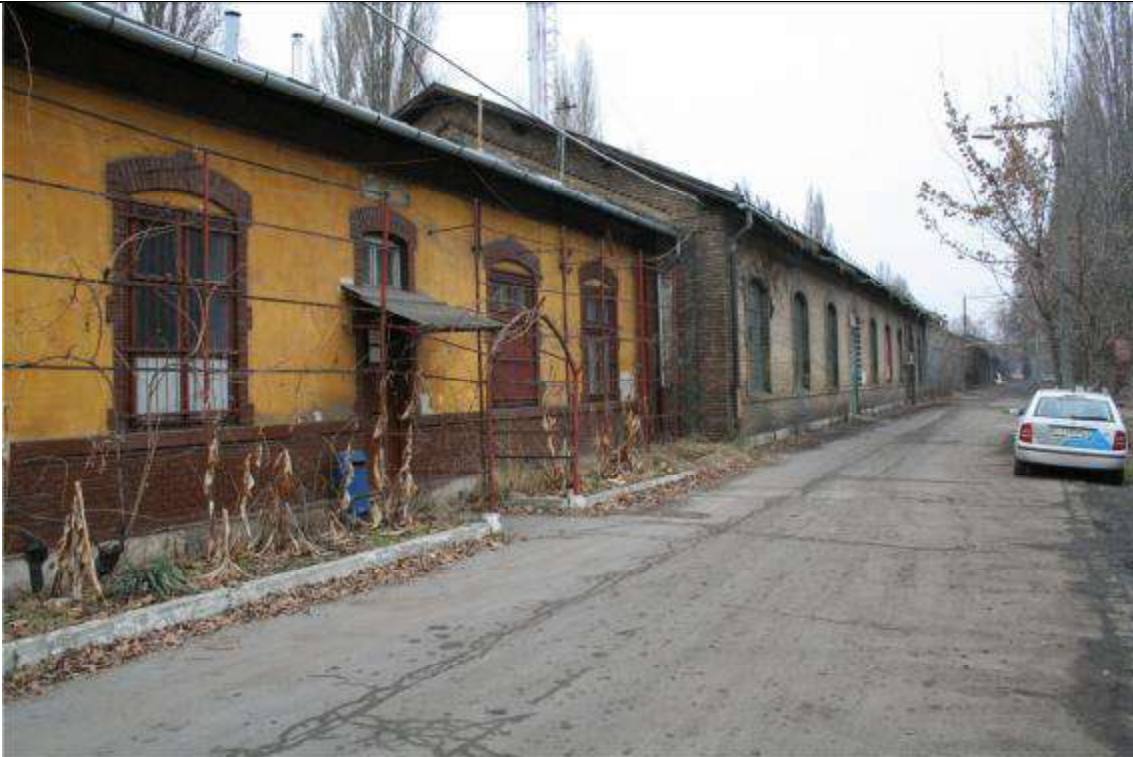
Jellemző homlokzati fotó
