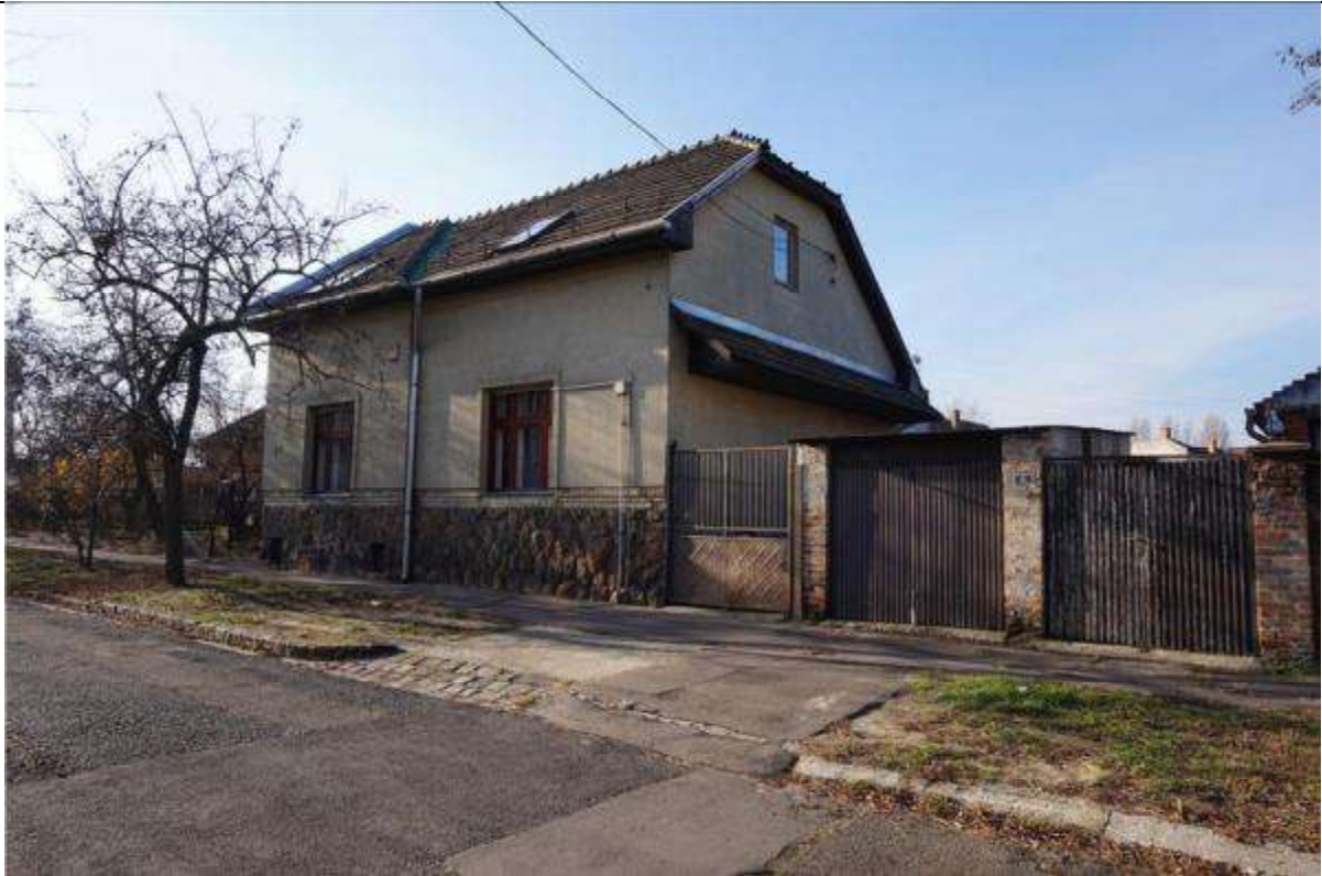
Jellemző homlokzati fotó
