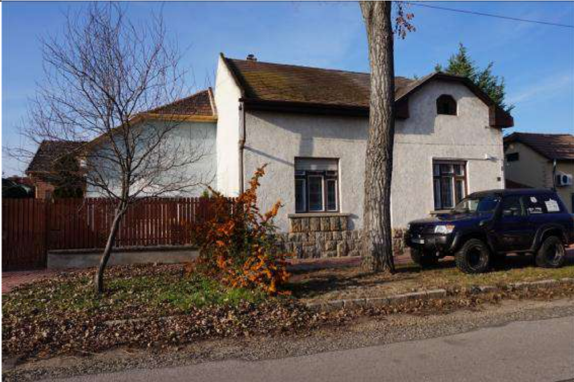
Jellemző homlokzati fotó
