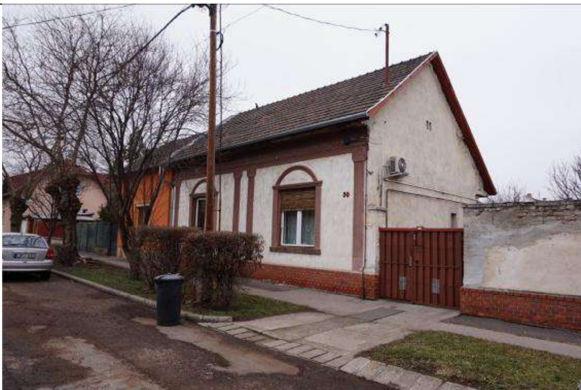
Jellemző homlokzati fotó
