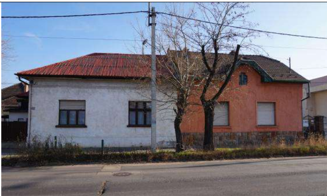
Jellemző homlokzati fotó
