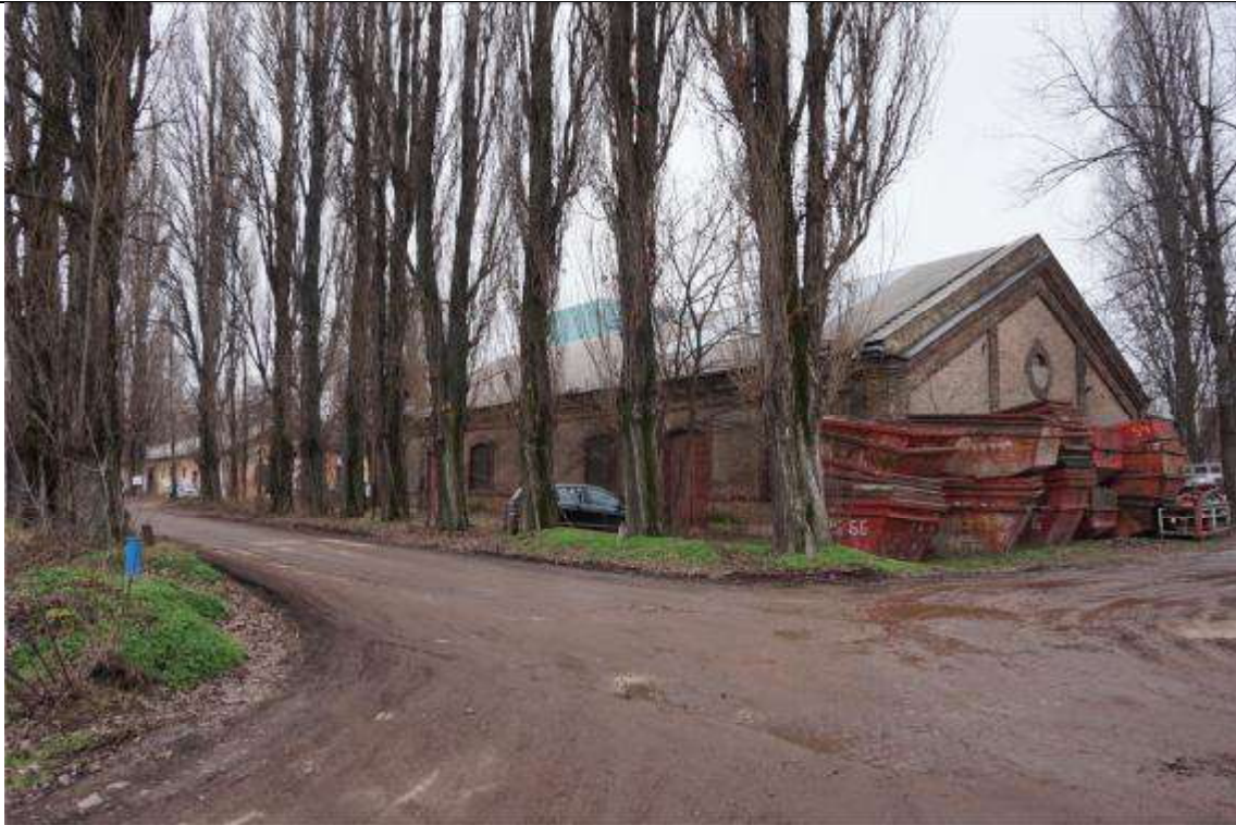
Jellemző homlokzati fotó
