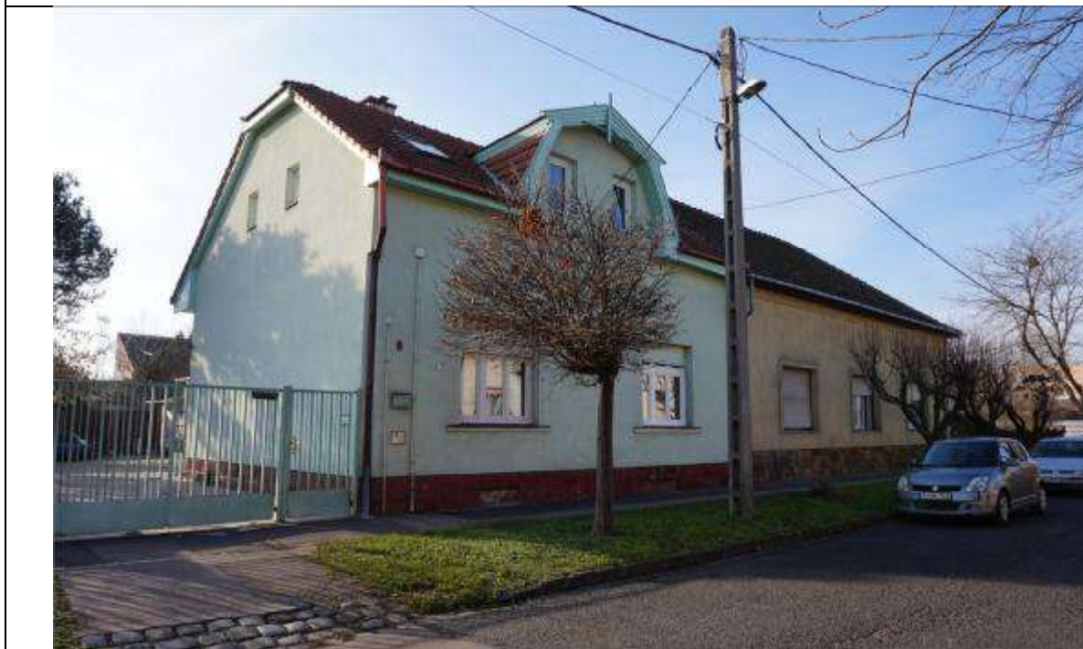
Jellemző homlokzati fotó
