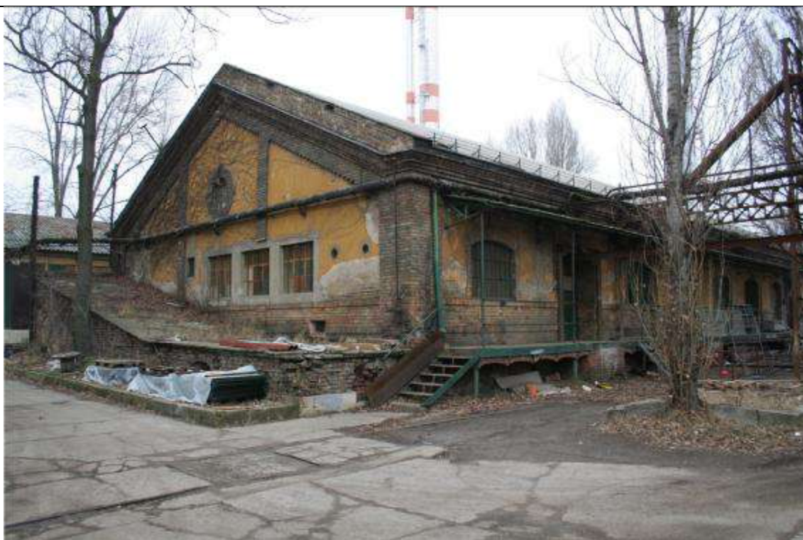
Jellemző homlokzati fotó
