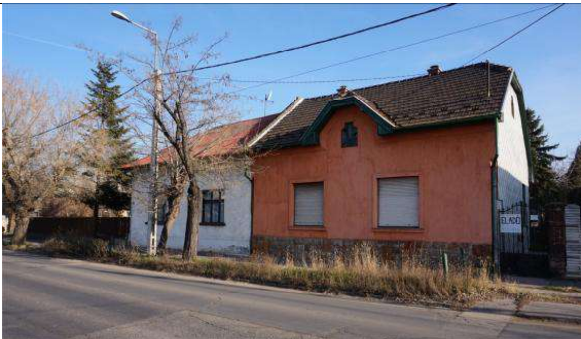
Jellemző homlokzati fotó
