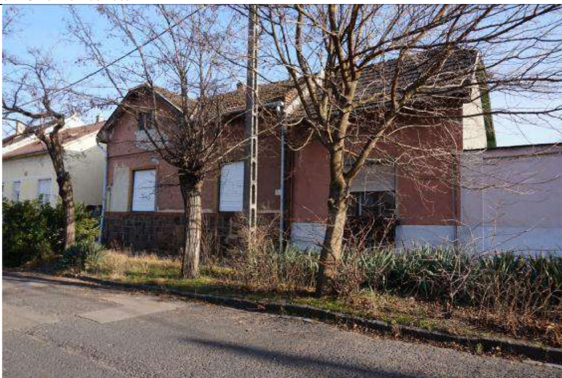
Jellemző homlokzati fotó
