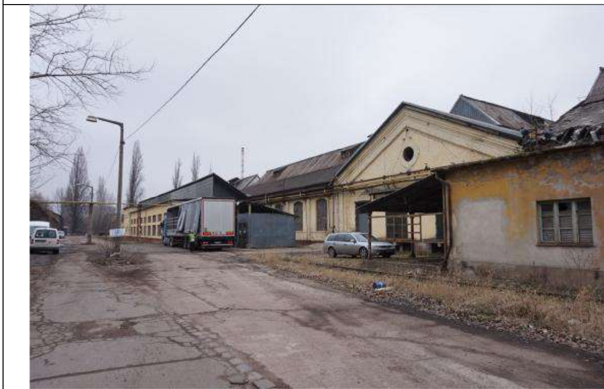
Jellemző homlokzati fotó
