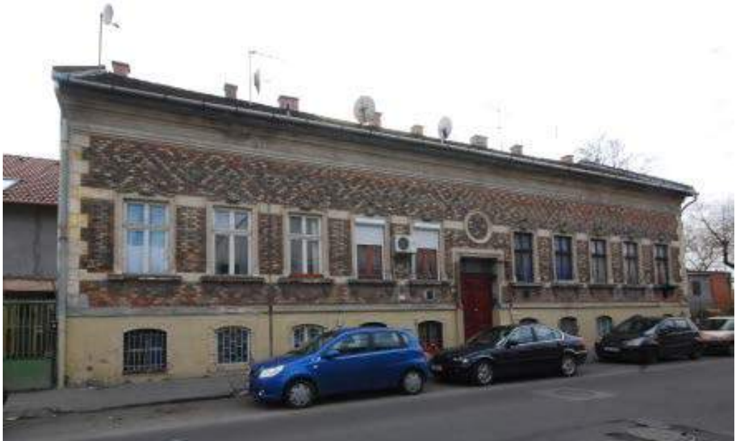
Baross utca felőli homlokzat
