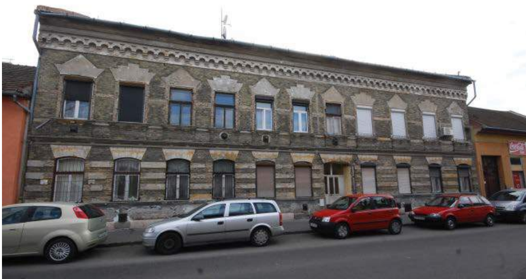
Baross utca felőli homlokzat
