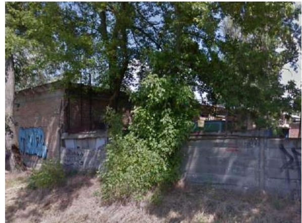
Népsziget úti gáznyomásszabályzó
