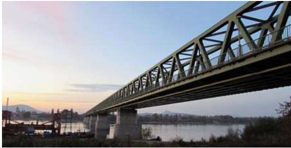
Újpesti vasúti híd
