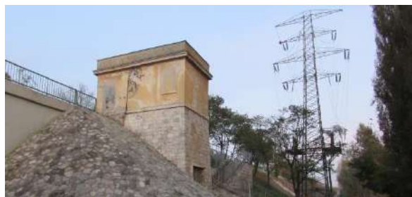
Légvezetékes hálózat része a vasúti híd mellett
