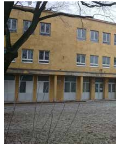
Használaton kívüli iskolaépület
