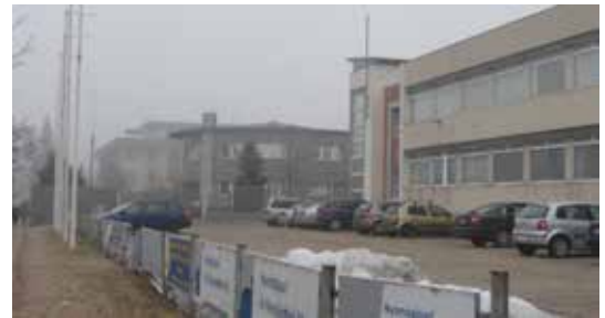
MACRO Medical Center épülete
