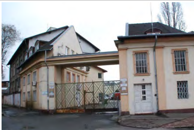
Erkel utca felőli homlokzat és udvar
