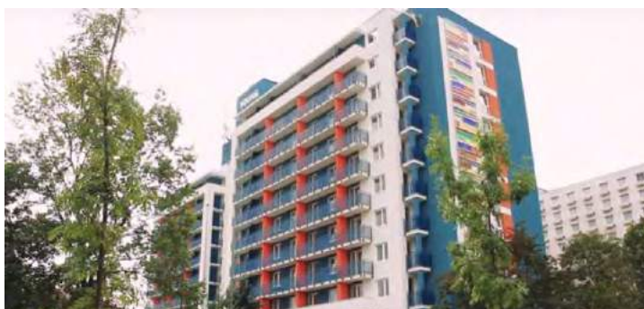
Új erkélyek építésével korszerűsített épület (Pünkösdfürdő 38.)
