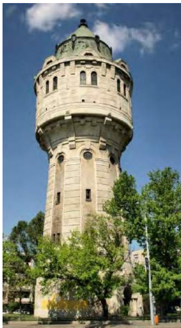
Üzemen kívüli Árpád úti víztorony
