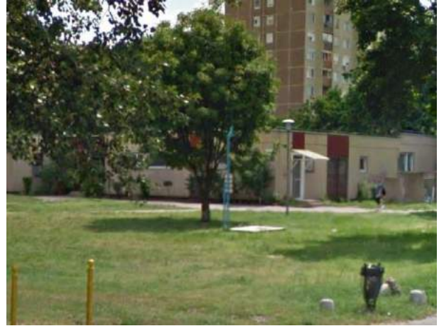
Földbe süllyesztett körzeti gáznyomásszabályzó a Viola utcánál
