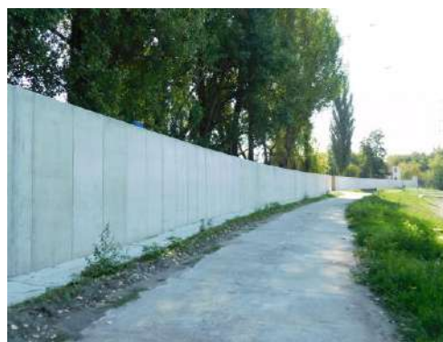
Új árvízi védműszakasz a Komp utca és Zsilip utca között
