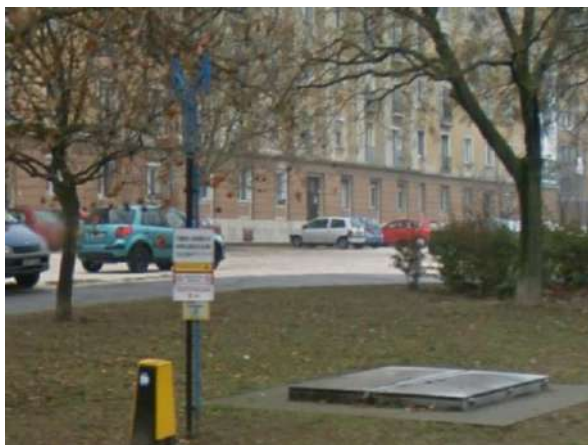
Földbe süllyesztett nagyközep/kisnyomású gáznyomásszabályzó a Szabadság parkban
