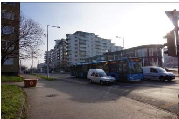
Tél utcai beépítés
