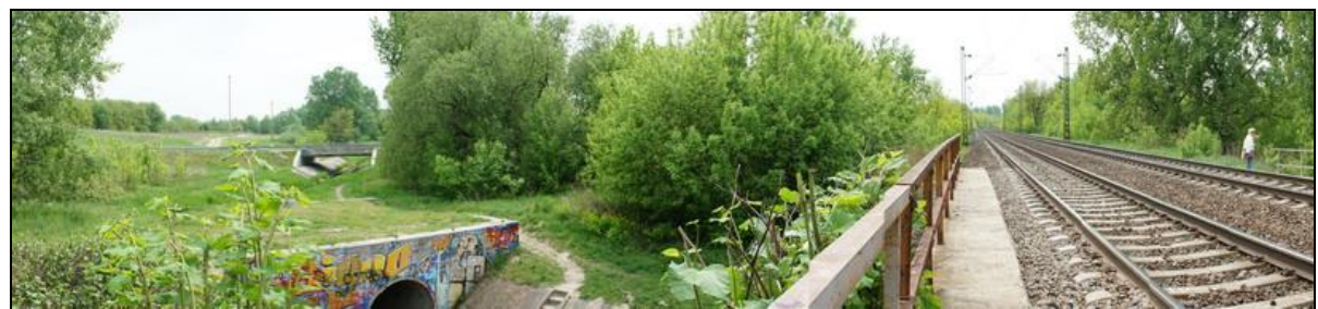
A közúti híd XV. kerületben, a volt vasúti híd és a jelenlegi vasúti műtárgy magassági viszonyai
